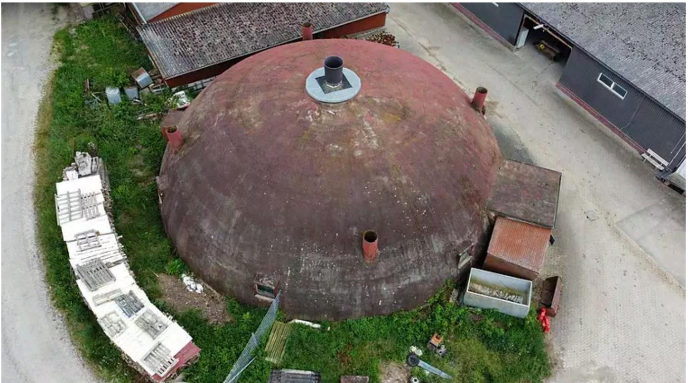
Foto: Markus Beutler | Für die sogenannten Binishells wird eine Blase gefüllt und geformt, der Beton erhebt sich in die Kuppelform.
