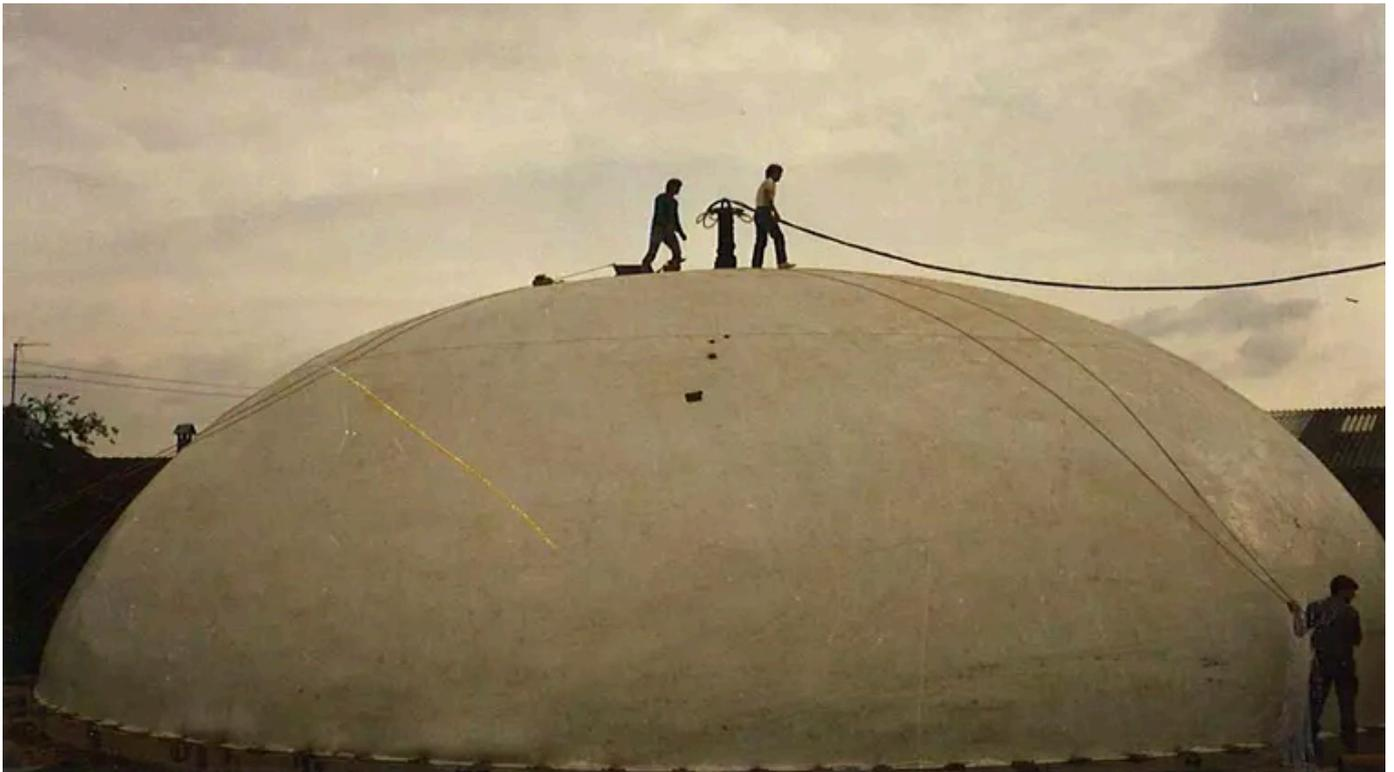
Foto: Emil Lang | In den 1980er-Jahren entwickelten Beutler & Lang sogar aufblasbare Schalungskonstruktionen.
